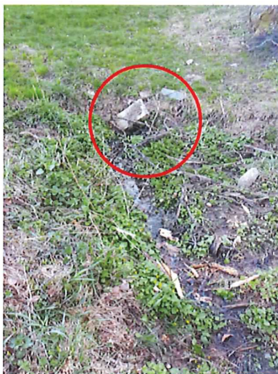
Figure 5 : Mise sous terre actuelle de l'affluent n°2 du ruisseau de la Rochette (état 18 avril 2018, entourée en rouge).
