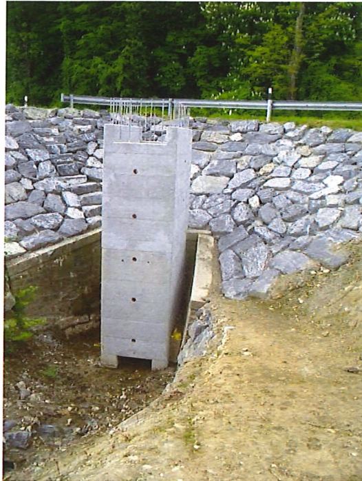
Figure 10: Exemple de réalisation d'une mise sous terre équipée d'un ouvrage de laminage sécurisé contre les cas d'obstruction (ruisseau du Flumeau à Lavigny, photo Stucky SA)
