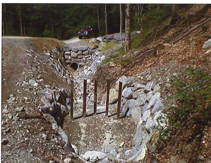
Figure 5 : Exemple de réalisation d'une herse (Bey de Sérison à Bex, photo Stucky SA)
